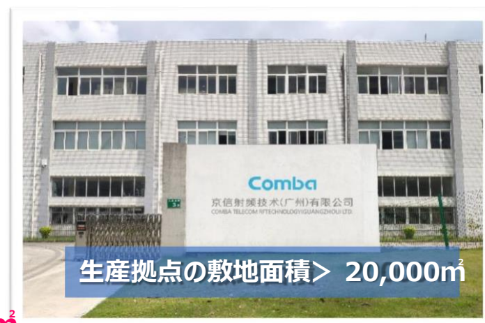
5Gアンテナとフィルタ生産拠点_広州
